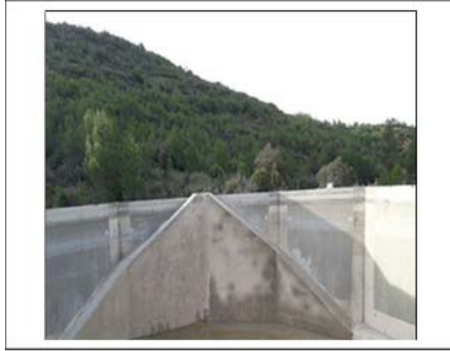
Imatge 23: Rampa de fauna d'obra per punt d'aigua.
