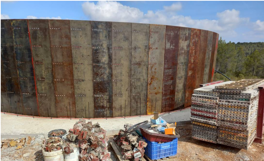
Imatge 20: Exemple d'encofrat en el punt d'aigua d'Avinyonet (PPP Garraf).
