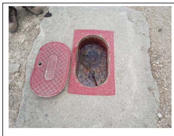
Imatge 21: Exemple del sistema d'abastiment automàtic amb boia de control i punt de captació al camí d'accés als camps
