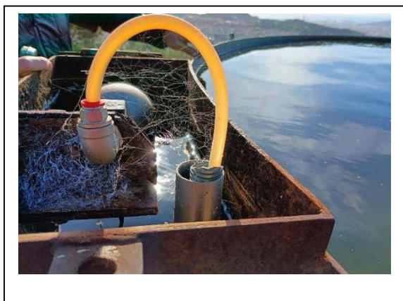
Imatge 21: Exemple del sistema d'abastiment automàtic amb boia de control i punt de captació al camí d'accés als camps
