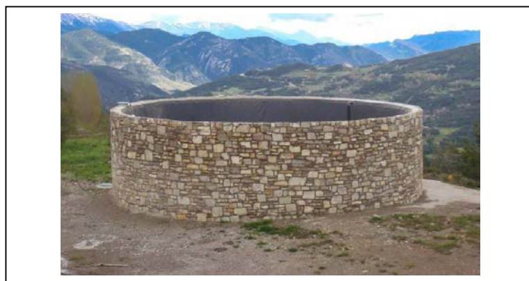
Imatge 25: Exemple de recobriments de les parets amb pedra (foto: Imper Serveis Comas SL)
